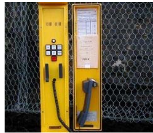
Notruffernsprecher geöffnet
