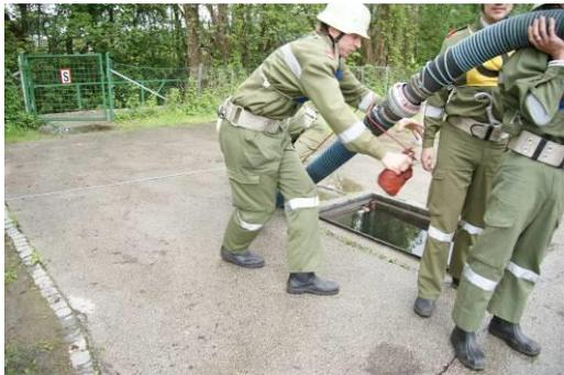
Der WTRF (Nr. 3) hakt den Karabiner der Saugerleine in den vorgesehenen Ring (Öse - fester Ring) am Saugkopf. Er darf ihn nicht in den für die Ventilleine bestimmten Ring (Öse) einhaken. Nun zieht er die Saugerleine aus dem Beutel und legt bei allen Kupplungspaaren je einen ganzen Schlag um den wasserseitigen Saugschlauch in der Art, dass die Saugleitung eine schwach gekrümmte Wellenlinie bildet.
